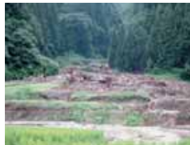
棚田の被災状況（栃尾市栃堀）
